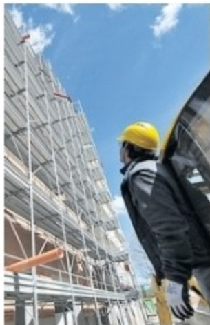
Un cantiere edile
